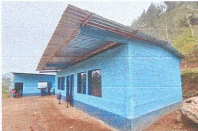
Foto1: Vista modulos rehabilitados
