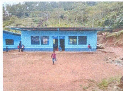
Foto: Panorámica frontal modulos rehabilitados.
