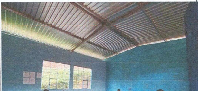
Foto 5: Vista Techo de modulos rehabilitados
